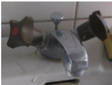
Figur 16: Äldre blandare av 2-grepps typ, inte snålspolande
