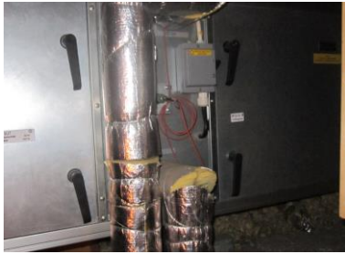
Figur 18: Befintligt tilluftaggregat
